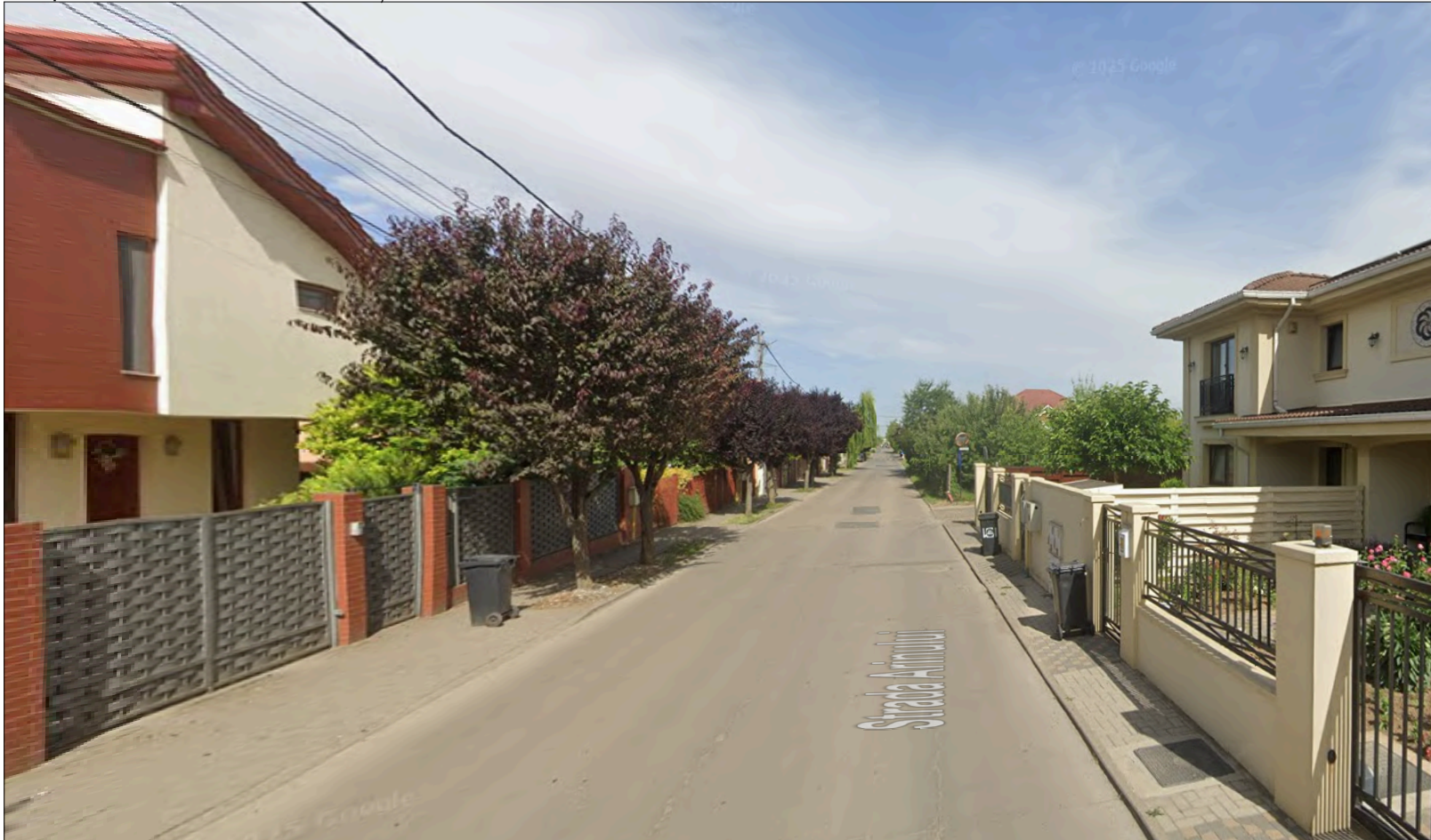
Perspectiva 1: Strada Arinului. Situație existentă
