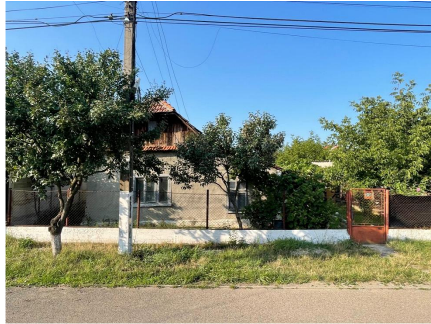
FOTO EXISTENT CASA C1
